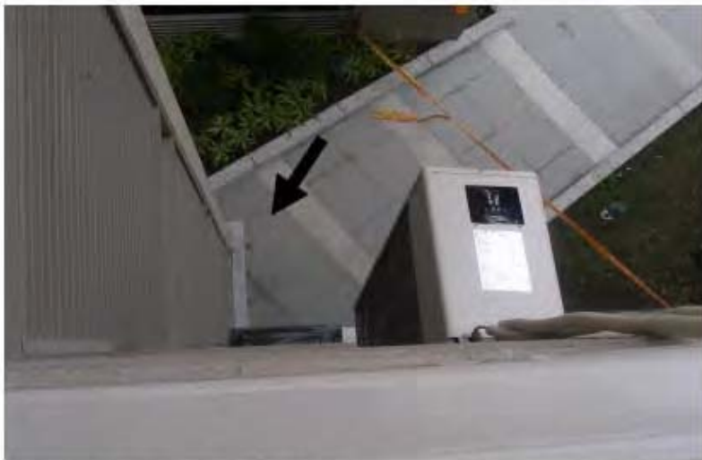
事故現場俯視圖，以箭號標示罹災者墜落地點。
