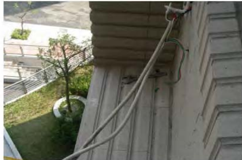
事故現場5樓施工平台。
